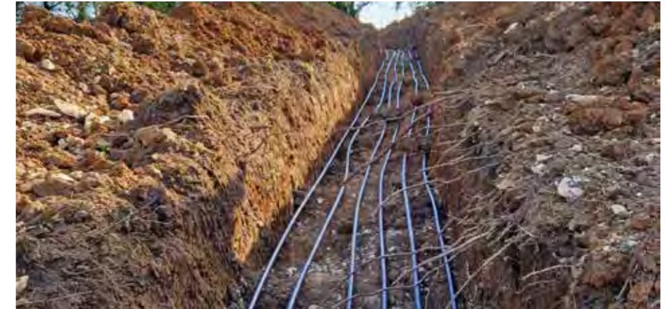
Leitungsraben eines Flächenkollektors in der Nähe von Ebermannstadt
